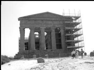
...Cantieri nella Valle dei Templi...
